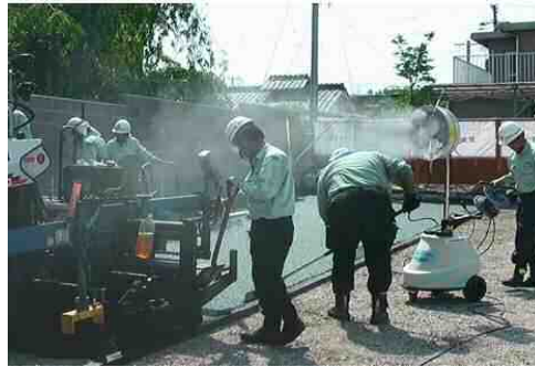
【土木現場】作業員の熱中症対策
